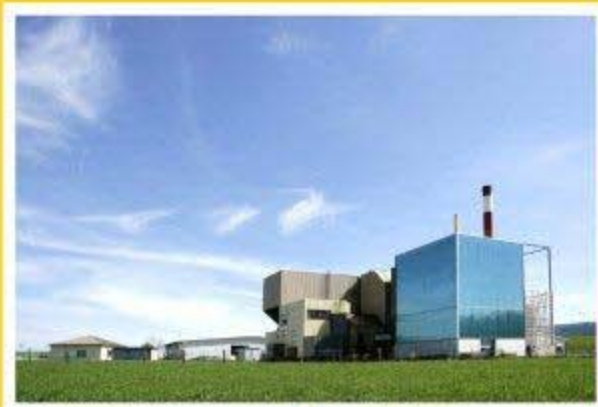
Centre de Traitement et de Valorisation des Déchets du Haut-Doubs (siège du SMETOM)
